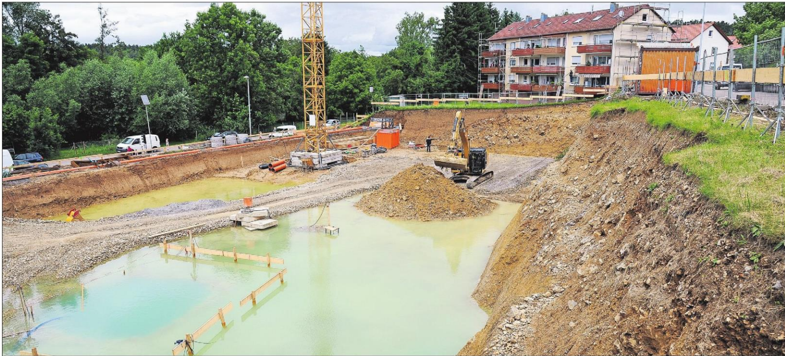
Die Niederschläge der letzten Tage haben die Baustelle neben der Malmheimer Straße in Weil der Stadt geflutet. Auf dem Grundstück der Bezirksbaugenossenschaft Altwürttemberg entstehen drei Neubauten mit 48 Mietwohnungen Foto: Thomas Bischof
