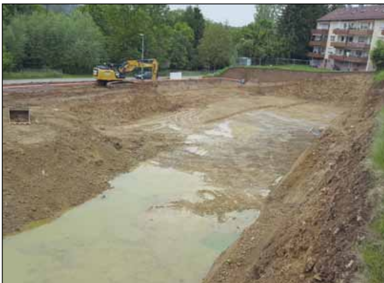
Baugrube Weil der Stadt
