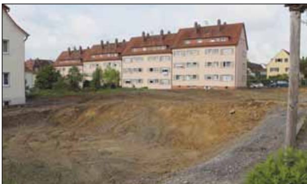
Baugrube Ulrichstraße, Ludwigsburg
