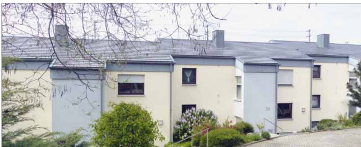
Alte Renninger Straße, Weil der Stadt
