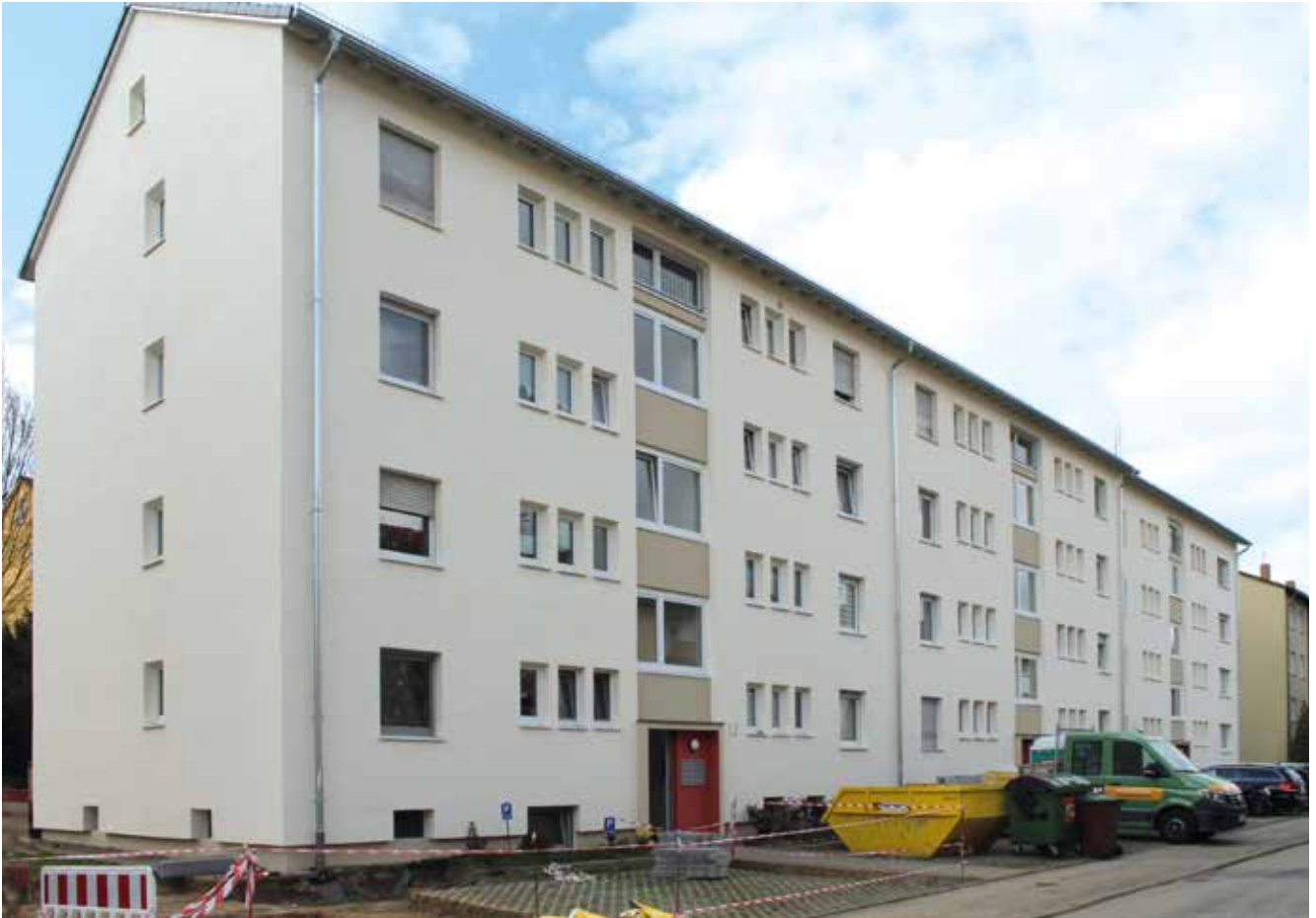
Außenfassade, Traifelbergstraße 8 – 12, Kornwestheim
