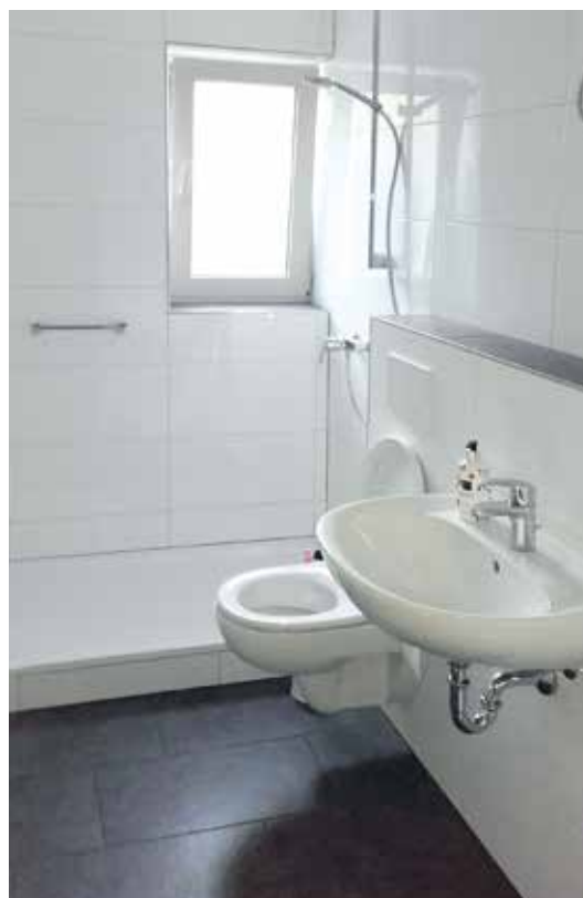
Badrenovierung, Traifelbergstr. 8 – 12, Kornwestheim
