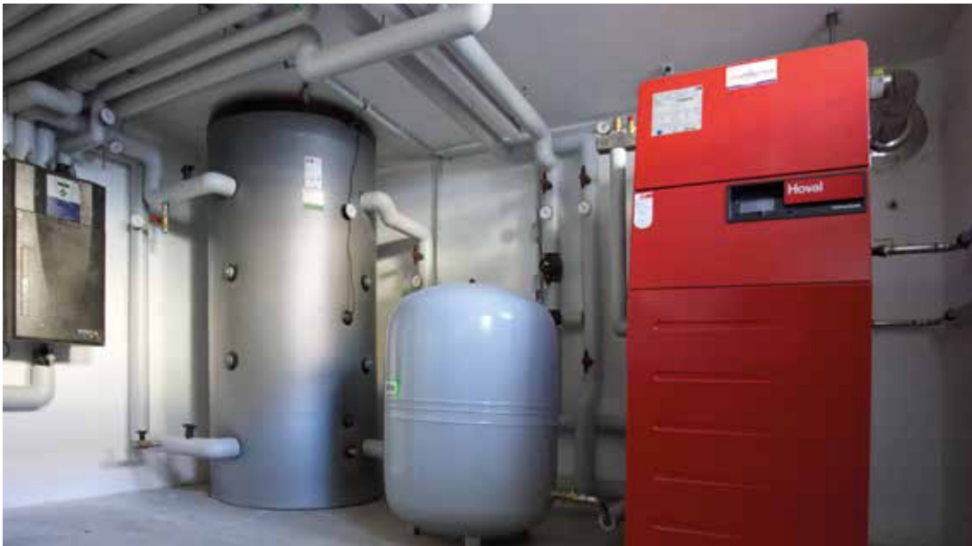
Einbau einer zentralen Heizungs- und Warmwasseranlage in der Traifelbergstr. 8 – 12, Kornwestheim
