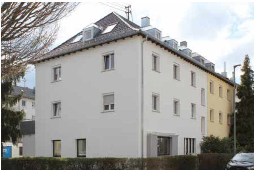
Außenfassade, Friedrich-Siller-Straße 58, Kornwestheim
